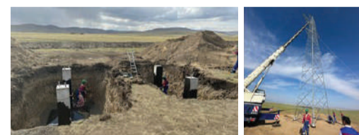
Хөл суурилуулж байгаа нь Эхний тулгуур боссон байдал
