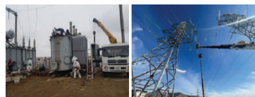
Багахангай дэд станцын Т-1 трансформатор солих ажил 205,206-р АШ-н ажлын явц
